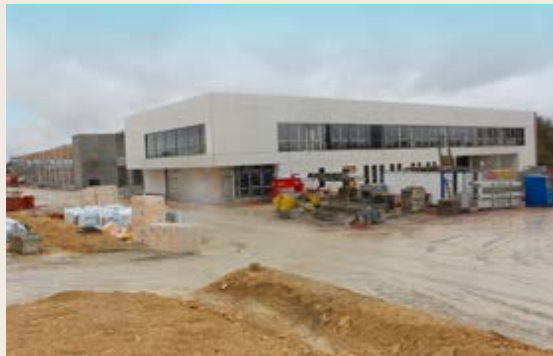
Le chantier du centre de maintenance.
