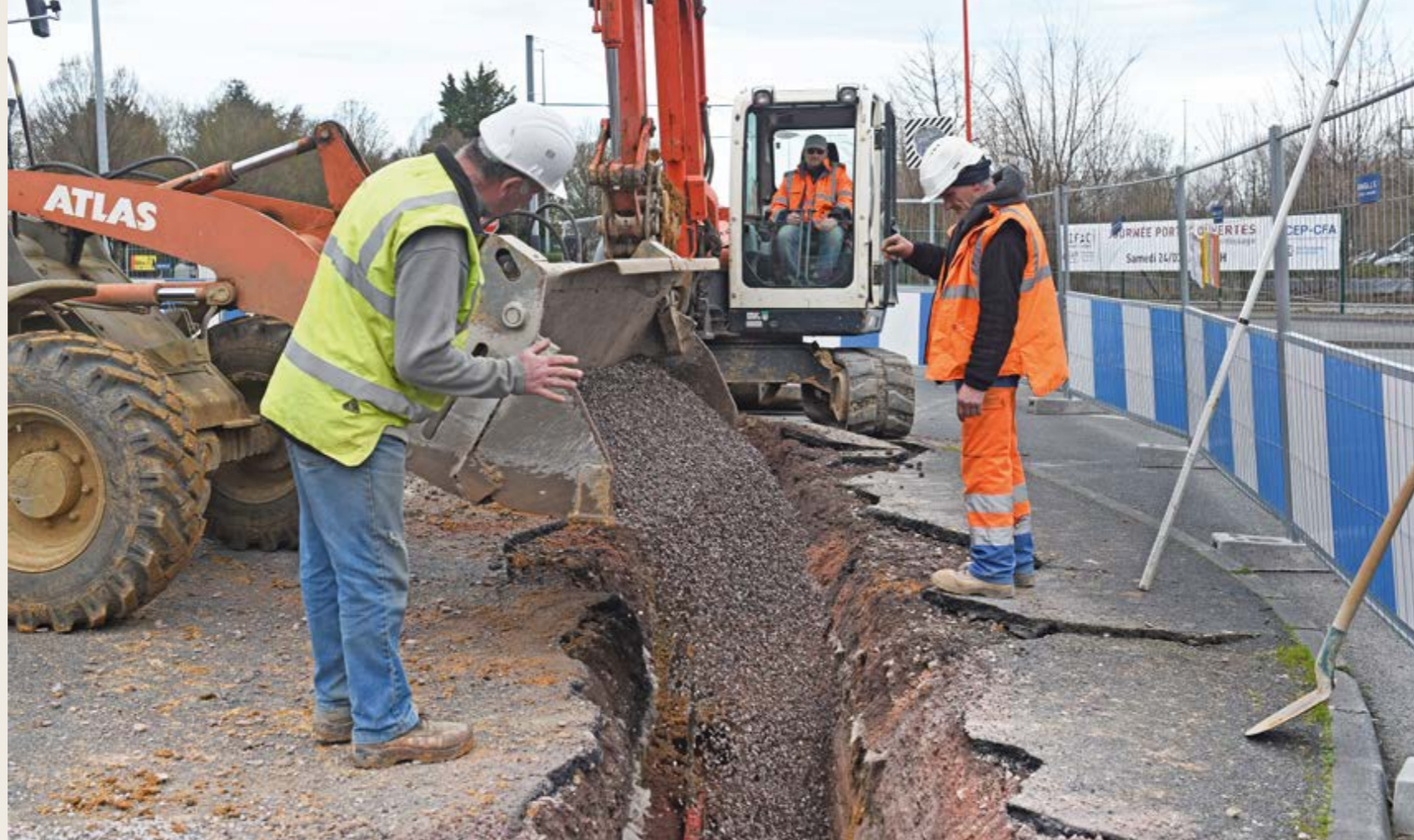
Le chantier rue Claude Bloch à Caen.
